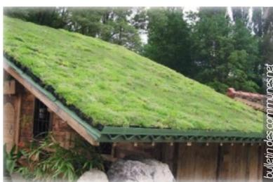
Principalement constituée d'un substrat permettant l'accueil des végétaux, d'une couche filtrante et d'une couche de drainage, la toiture végétalisée permet de ralentir les eaux ruisselant sur le toit et d'en absorber une partie.
