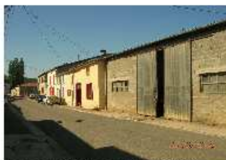
hangar 20 Grande Rue (0098)
