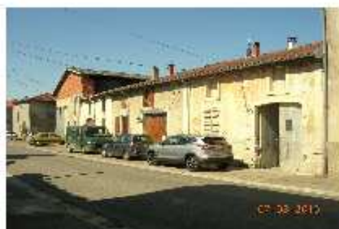
10 Grande rue (0102) réhabilitation partielle à conforter
