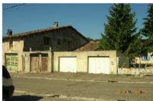
40 Grande Rue (0094) incohérences architecturales
