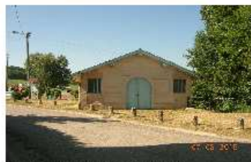
ancien lavoir rénové (0106)
